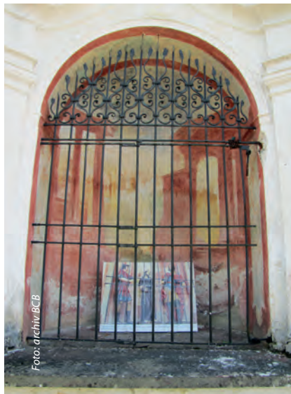
Po odcizení soch Piláta a Ježíše Krista v roce 2009 byly sochy v kapli „Malý Pilát“ nahrazeny fotografickým panelem se zobrazením původních soch.
