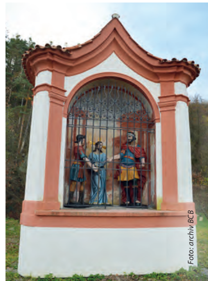
Kaple „Malý Pilát“ dnes. Při renovaci římovské pašijové cesty byly opraveny všechny kaple, do kterých byly vytvořeny i kopie původních soch.
