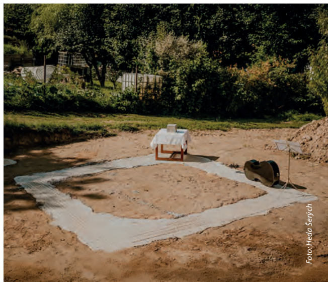
P. Stanislav Brožka zehňuje základy nové kaple v Zubčicích.
