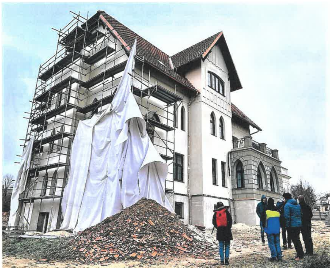
V roce 2022 byla zahájena rekonstrukce fary v Dobré Vodě u Č. Budějovic; Foto: archiv DCHCB
