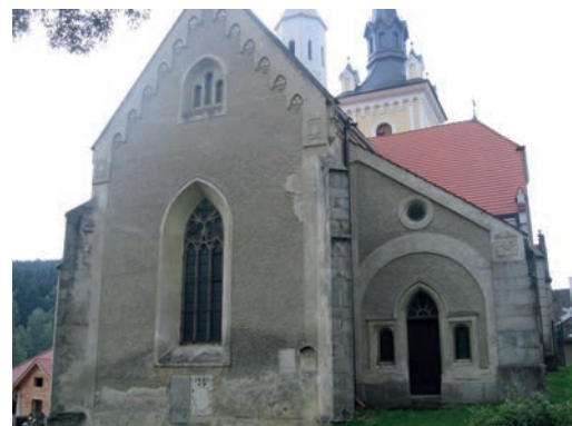
Kostel před opravou; Foto: archiv BCB
