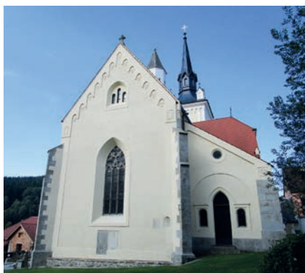
Kostel po opravě; Foto: archiv BCB
