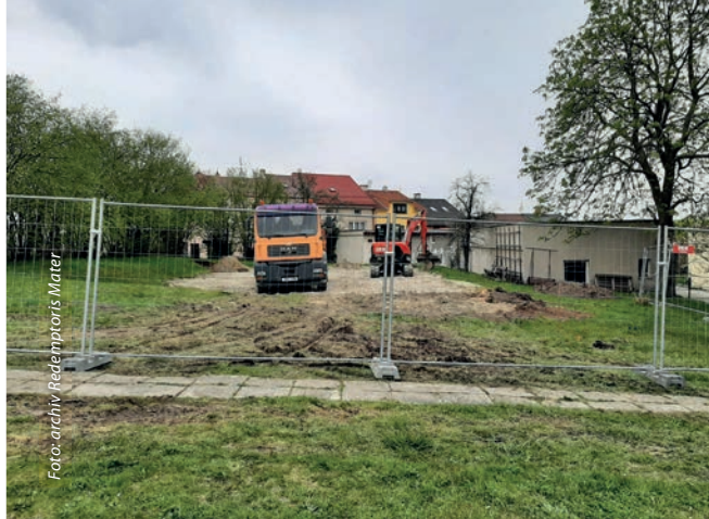
Probíhající stavební práce na budování nového hřiště.
