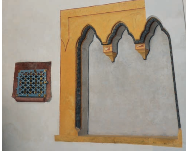
Bylo mimo jiné objeveno a obnoveno zazděné gotické sedile – původní stav (vlevo) a vzhled po opravě (vpravo); Foto: Jana Kurková
