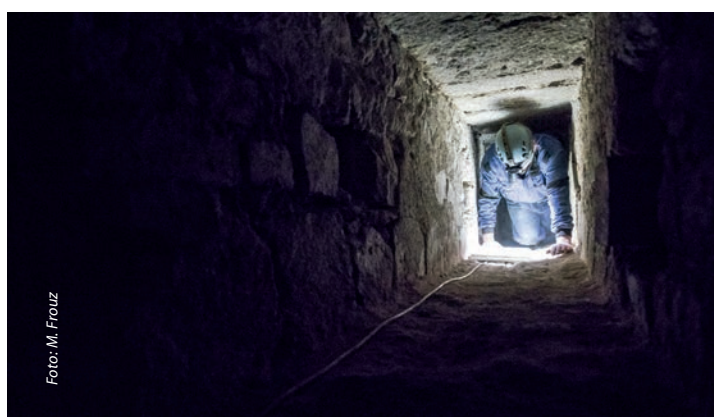
Vstupní chodba do trezorové místnosti.
