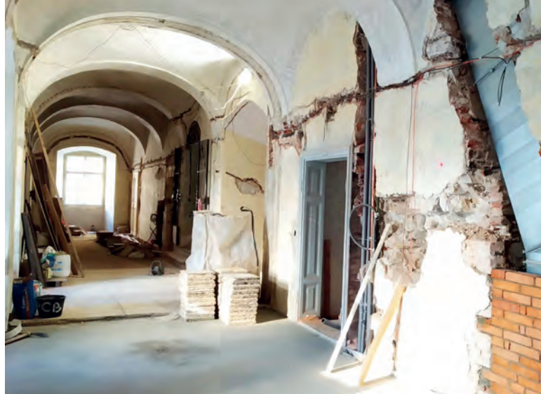
V celé budově jsou nové zdravotní instalace, rozvody topení, elektřiny a klimatizace, opravené omítky a nové podlahy; Foto: archiv BCB
