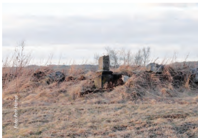
Tak vypadalo torzo prvního kříže v Budičovicích, který Petr Hanus začal opravovat v roce 2012.
