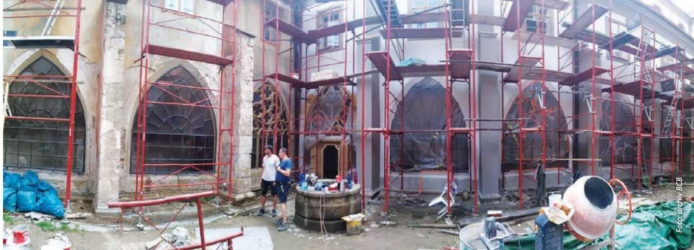
Všechny budovy získaly novou fasádu – zde je vidět oprava ambíků v rajske zahradě
