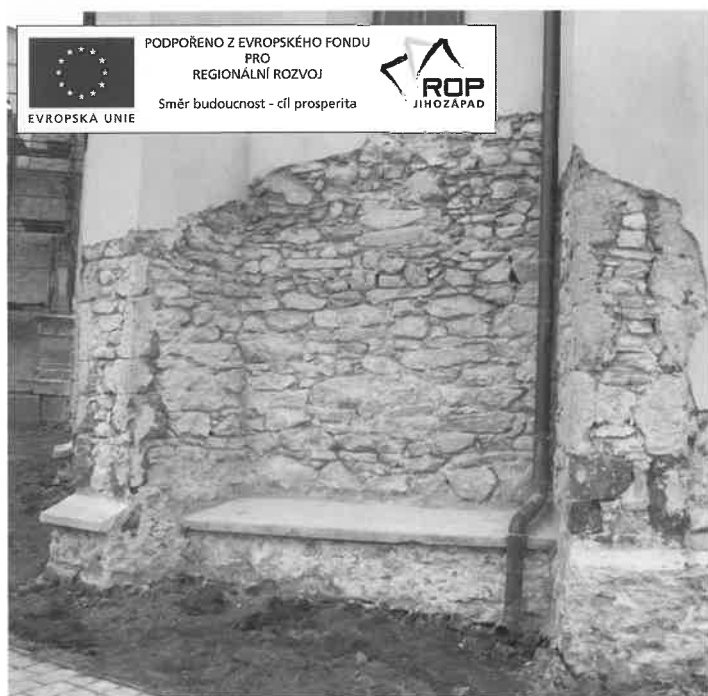
Otlučená omítka pro provedení sanačních omítek
