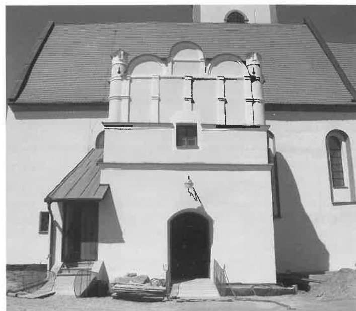
Dokončená oprava fasády
