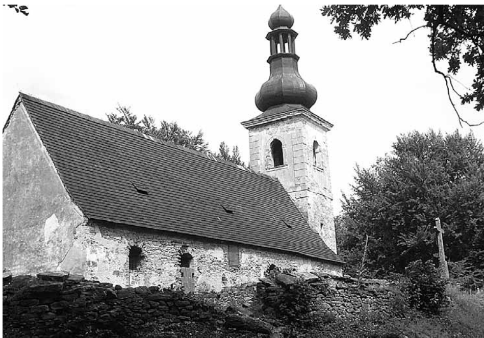
Pohled na kostel s věží
