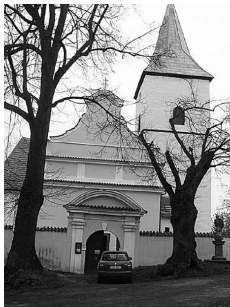
Kostel po opravě.
